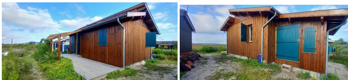
Figure 3 - cabane de gestion n°21 hors d'eau et hors d'air
