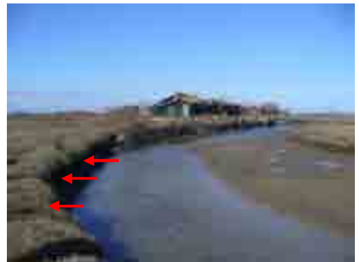
Erosion des berges au quartier Saous
