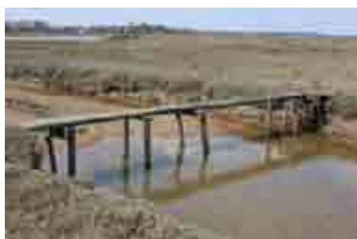
| Franchissement sous forme d'une passerelle
